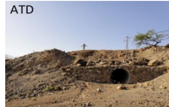
Vues de stations de l'extérieur
